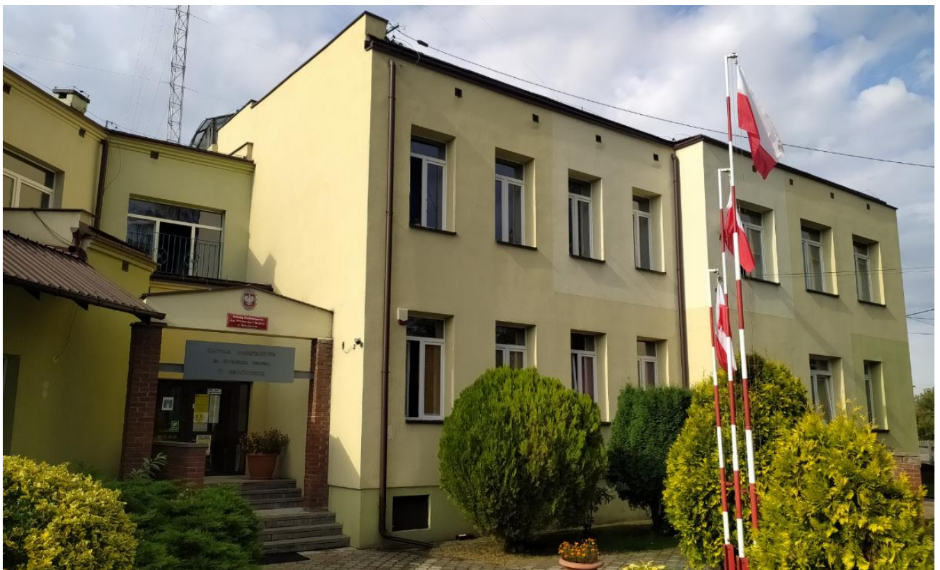
Rysunek 4 Elewacja frontowa budynku [zdjęcia z inwentaryzacji własnej]
